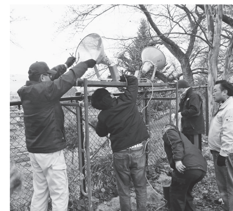
4月10日に行われた取り付け作業
