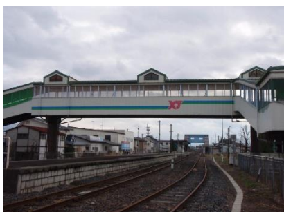
▲JR左沢線を跨ぐ横断歩道橋 (山辺駅構内横断歩道橋)
