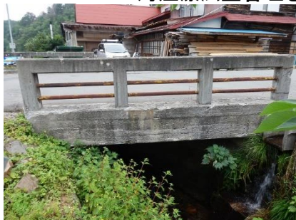
▲小規模な床版橋(鶴川橋)
