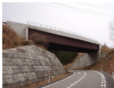
▲主要幹線に位置する跨道橋 (作谷沢湧水橋)
