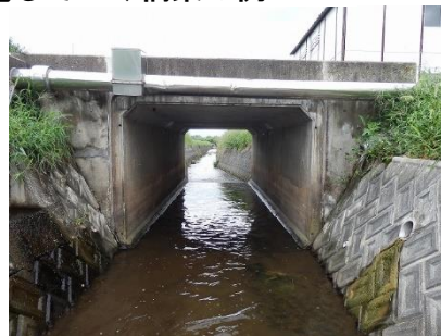
▲ボックスカルバート橋(中道橋)
