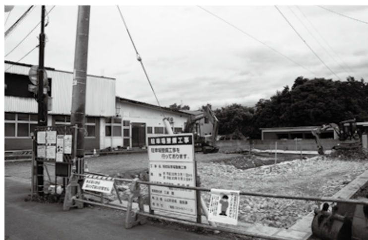
平成30年8月をめどに、駅前広場を駐車場として整備する。町内商店を利用する方や観光客、また駅利用者の送迎時の一時待機などに利用される。
