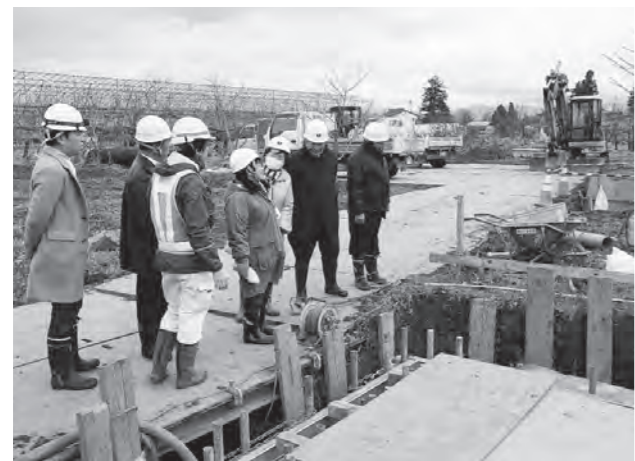
工事現場視察の様子
