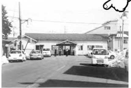
平成31年度改築完成予定の羽前山辺駅舎
