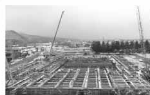
立谷川新施設工事現場
