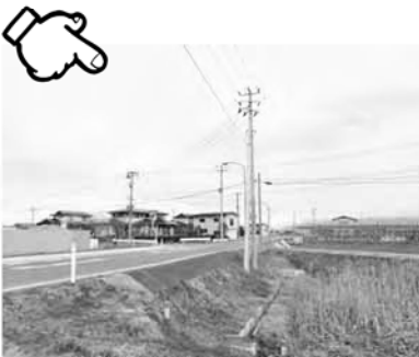
X字交差点(急角度交差)は町内に多く危険(町道大門四本橋線の鶴田交差点)
