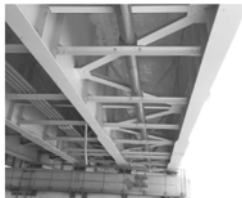
2月に完成した山形市との接続連絡管(鮎洗大橋)
